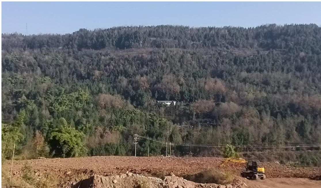
图 3.2-1 经开区十九路北（西溪村）处弃土场现状
