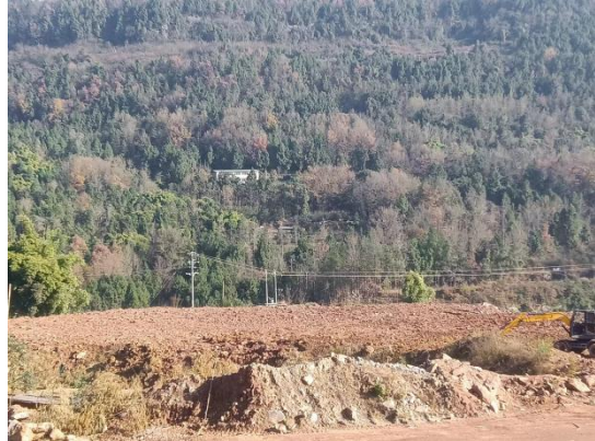
项目区弃方堆放现场（四）
